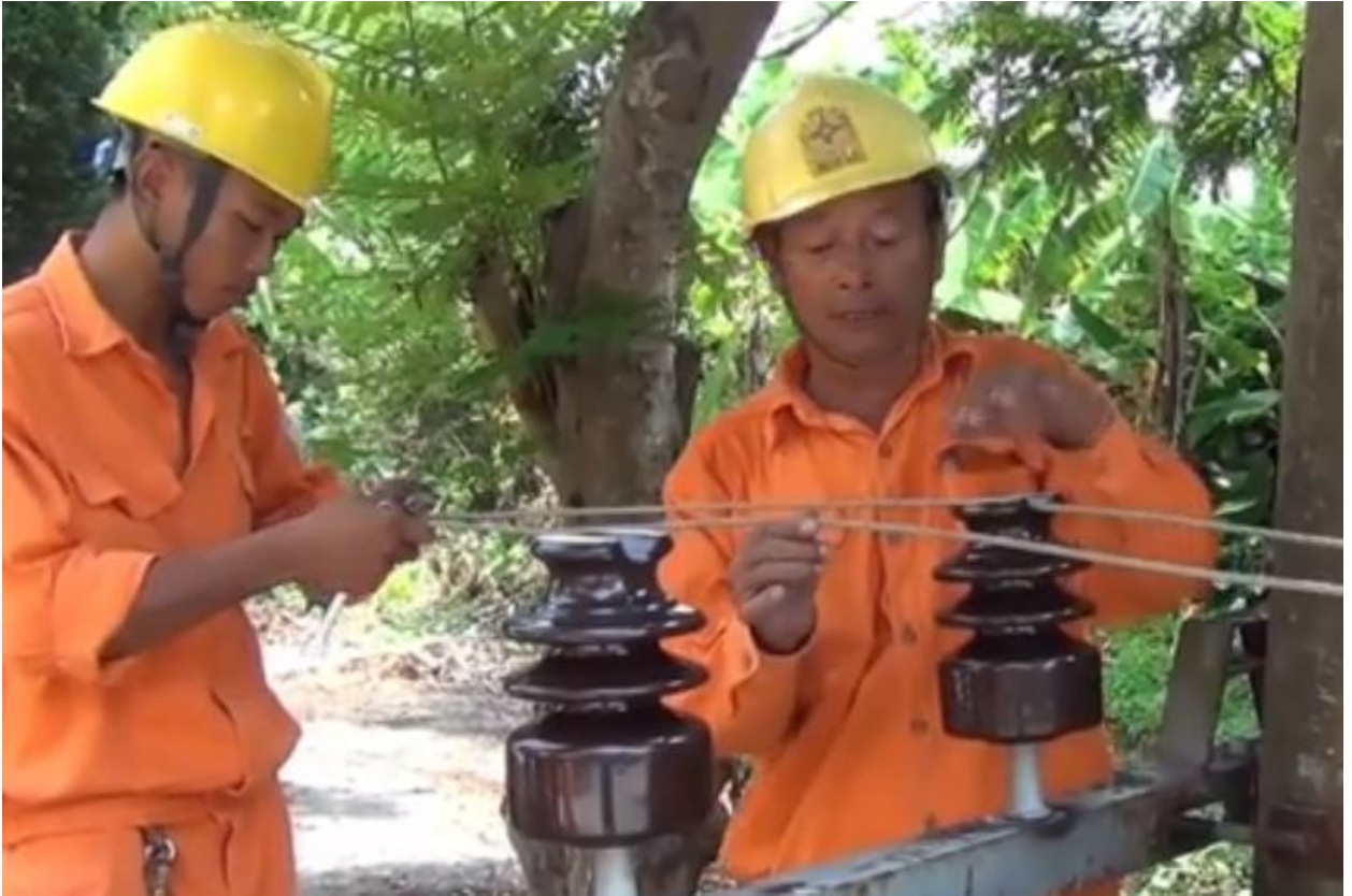
Hình 2.10. Cố định dây trên sứ cao áp
