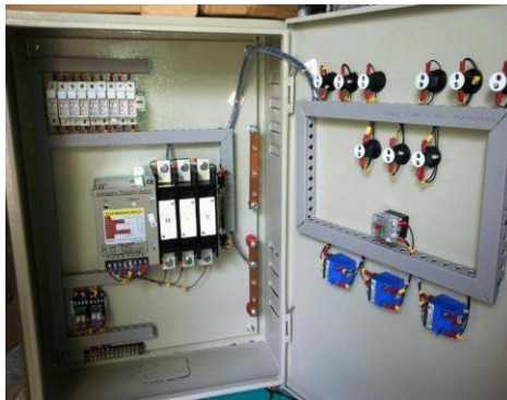
Hình 4.12: Đấu thiết bị cho tủ điện
